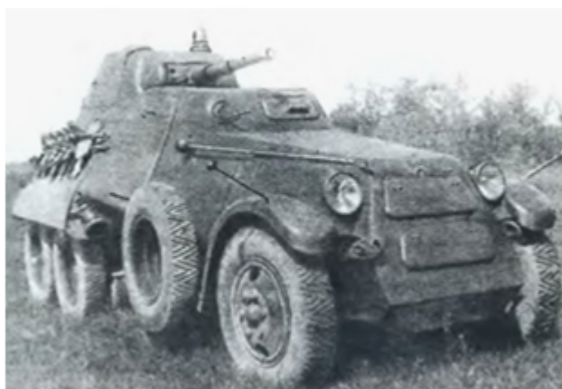
Рис. 3. Бронеавтомобіль БА-11 6х4 (СРСР, 1940)
