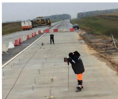
Рис. 4 – Работы по выравниванию плит дорожного полотна на участке 2-й МКАД
