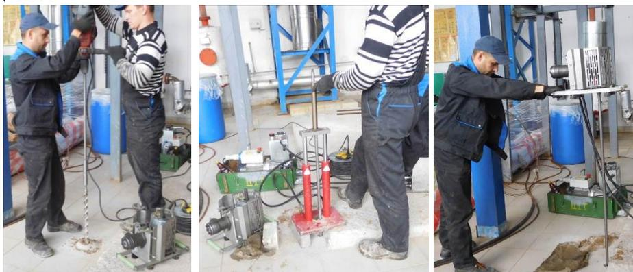
Рис. 2 – Проходка скважины внутри котельной СОО «Конте Спа» через высверленное отверстие в бетонном полу (а), извлечение штанг бура или зонда из скважины (б) и динамическое зондирование ґрунта в скважине (в)
