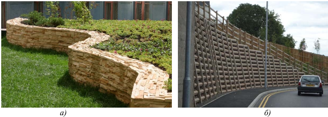
Рис. 1. Підпірні стінки: а) декоративна; б) несуча
