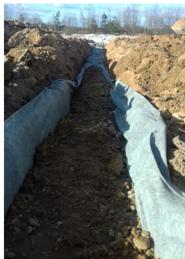
Рис. 1 – Сведения о площадке строительства а) геологические условия пятна застройки б) устройство дренажа
