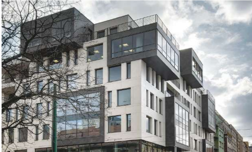
Рисунок 4 – Фасад будівлі, оздоблений плитками Laminam [2]
