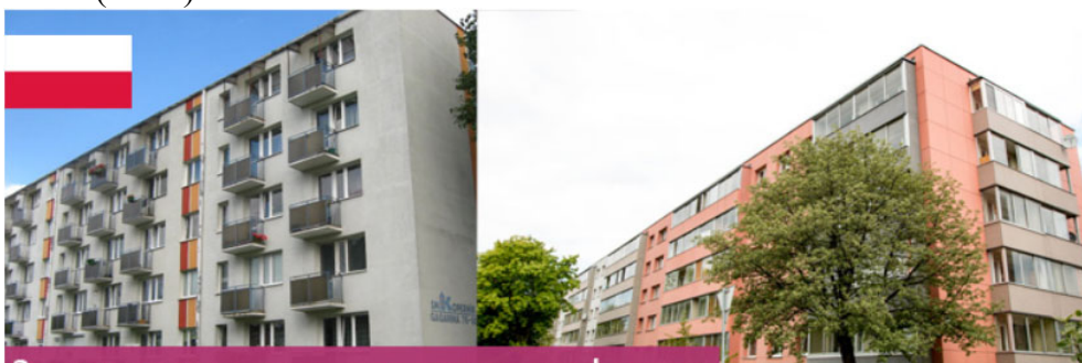
Рисунок 3 – Приклад реконструкції будинку в Польщі [3]
