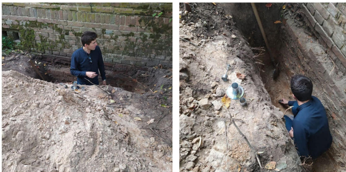
Рисунок 1 - Відбір ґрунтів для дослідження в шурфі з під підшови фундаменту
