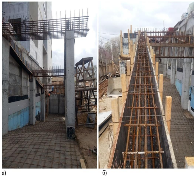
Рис. 1 – Виготовлення монолітних конструкцій на будівельному майданчику: а) монтаж арматури балок; б) встановлення металевих каркасів та опалубки
