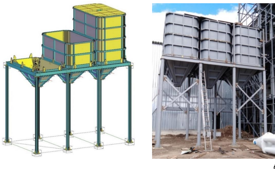
Рис. 9. Схема монтажу (а) та загальний вигляд спорудженого блока відвантаження (б)
