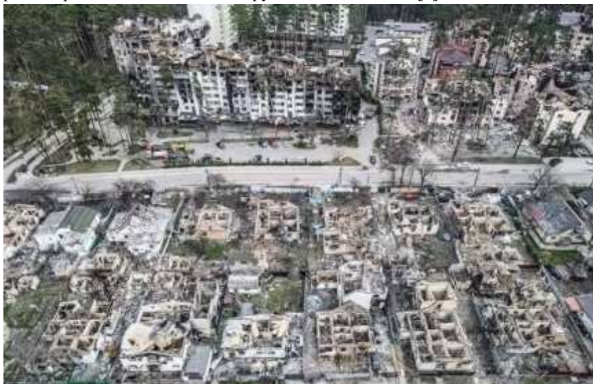
Рис. 1. Зруйнований житловий мікрорайон у м. Ірпені
