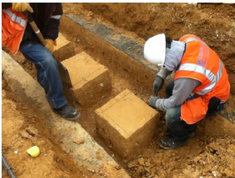
Рисунок 1.15 – Відбір монолітів ґрунту: а) вирізання [16]; б) пакування [17]
