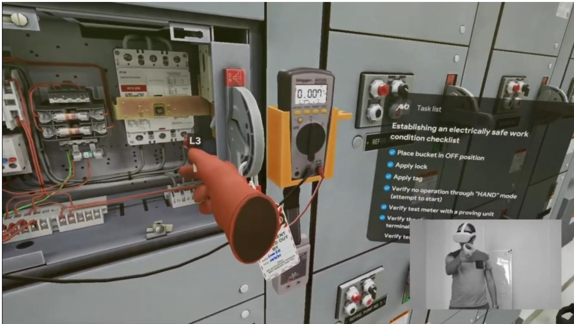
Рис. 1 – Перевірка відсутності напруги в розподільчому пристрої
