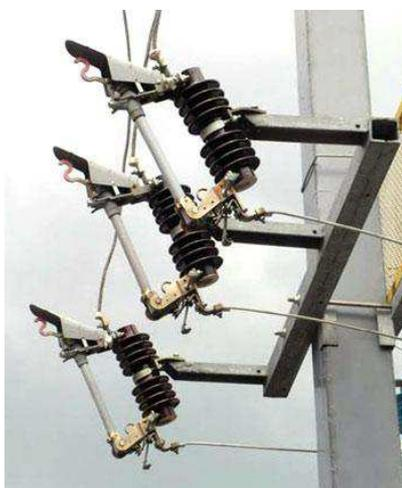
Рис. 2. Зовнішній вигляд предохранитель-разъединителя ПРВТ-10, встановленого на опорі повітряної лінії
